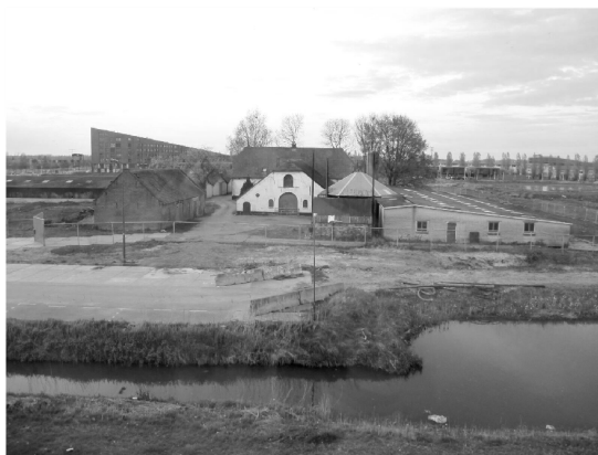
Fig. Boerderij Terwijde temidden van Leidsche Rijn in aanbouw, c. 2000. Foto: The Outsiders
